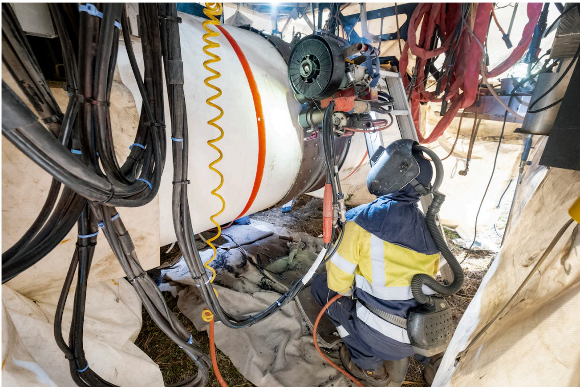
Pijpleidingen worden aan elkaar gelast. Beeld Raymond Rutting / de Volkskrant
